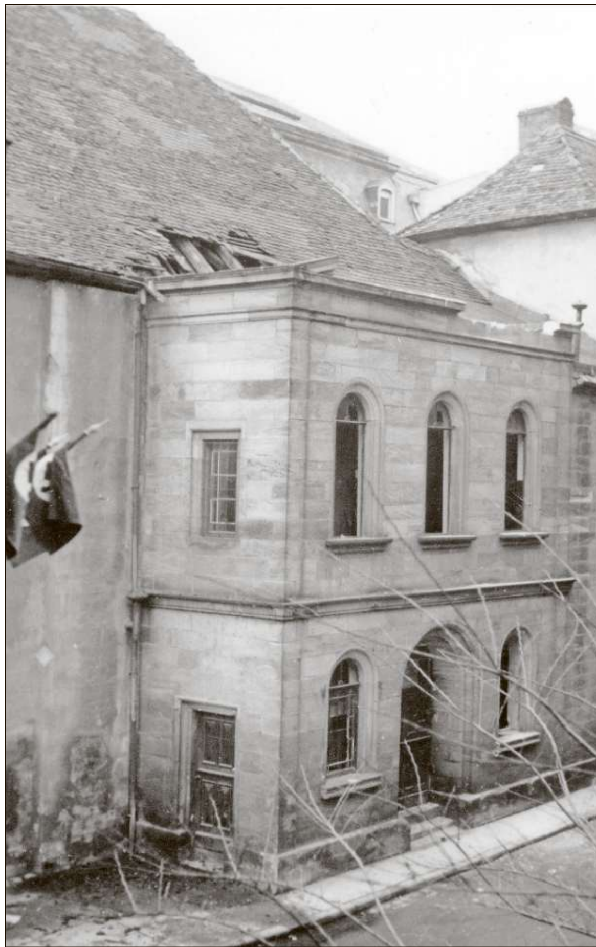
Die Synagoge in der Münzgasse, deren Innenraum vollständig zerstört wurde, wurde auch im Außenbereich beschädigt. In den frühen Morgenstunden des 10. November 1938 haben SS-Angehörige einige Quadesteine aus dem Mauerwerk gebrochen, bis sie von Polizisten gestoppt wurden. Foto: Stadtarchiv Bayreuth
